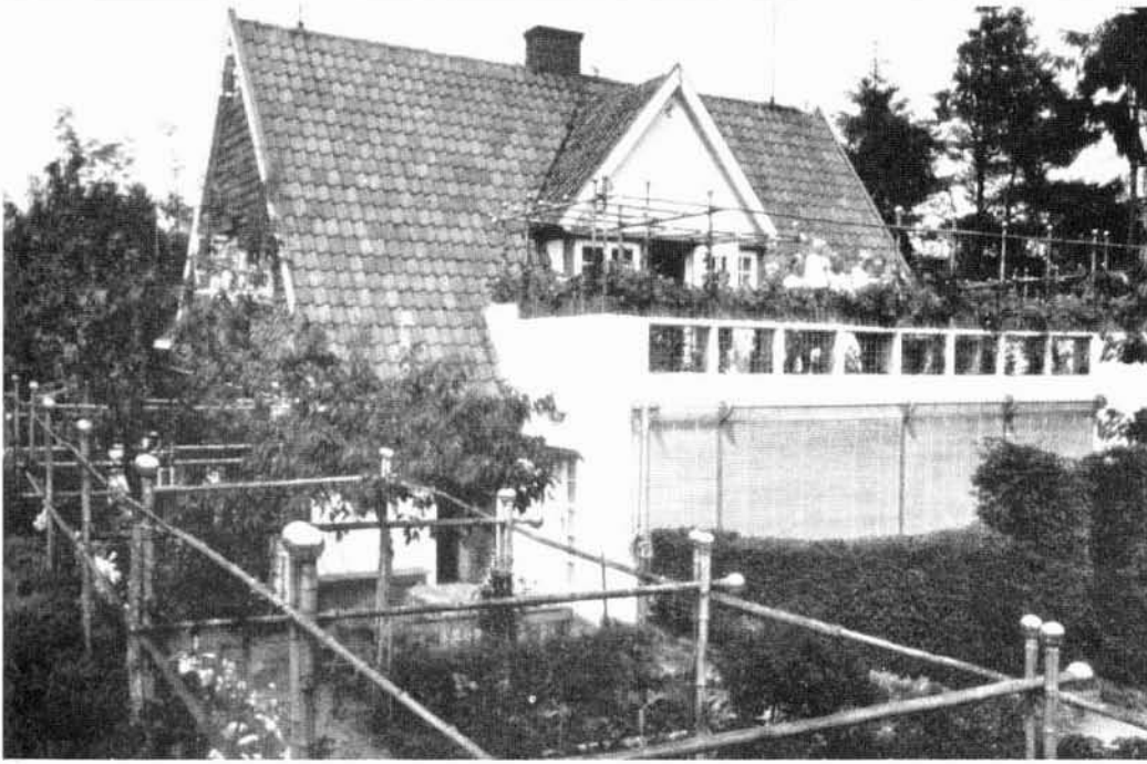
36/37 Die vor das Haus gestellte Glaswand wird mit einem Dachgarten überdeckt, so daß der Eindruck üppiger südlicher Vege- tation bis in das zweite Geschoß entwickelt werden kann.
