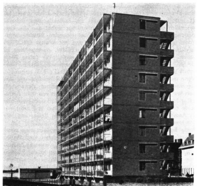
5 Rotterdam, Wohnhochhaus „Bergpolder Flat“. Willem van Tijen in Zusammenarbeit mit J. A. Brinkmann und L. C. van der Vlugt, 1934
